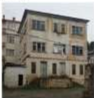
Görüş 7: Petrolüne ve Kütüphane binası, Giriş Cephesi.
